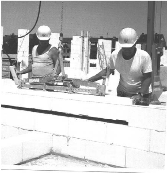
Рис. 7.14. Укладка блоков с помощью захватных устройств мини-крана
