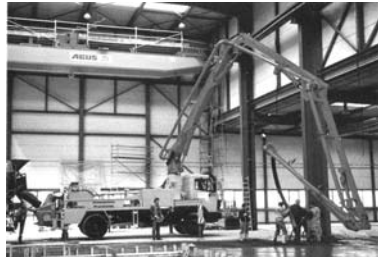
Рис. 2.10. Шарнирно-распределительные стрелы для укладки бетона
