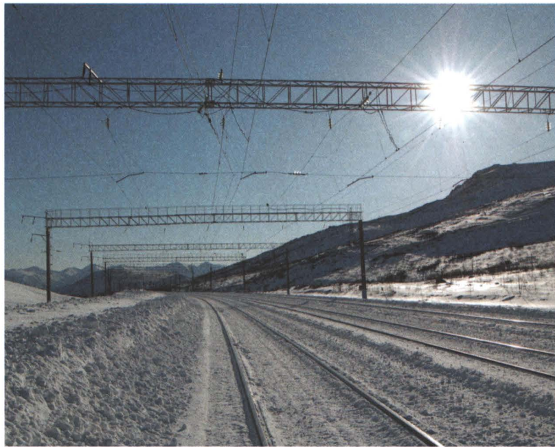
БАМ. Обход Северо-Муйского тоннеля
