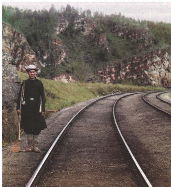
Башкирский стрелочник на перегоне между Уфой и Челябинском. Транссибирская магистраль. Фото С. Прокудина-Горского
