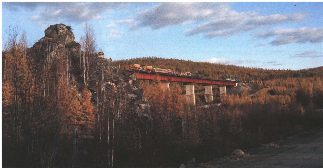
Ремонт моста на Байкало-Амурской магистрали
