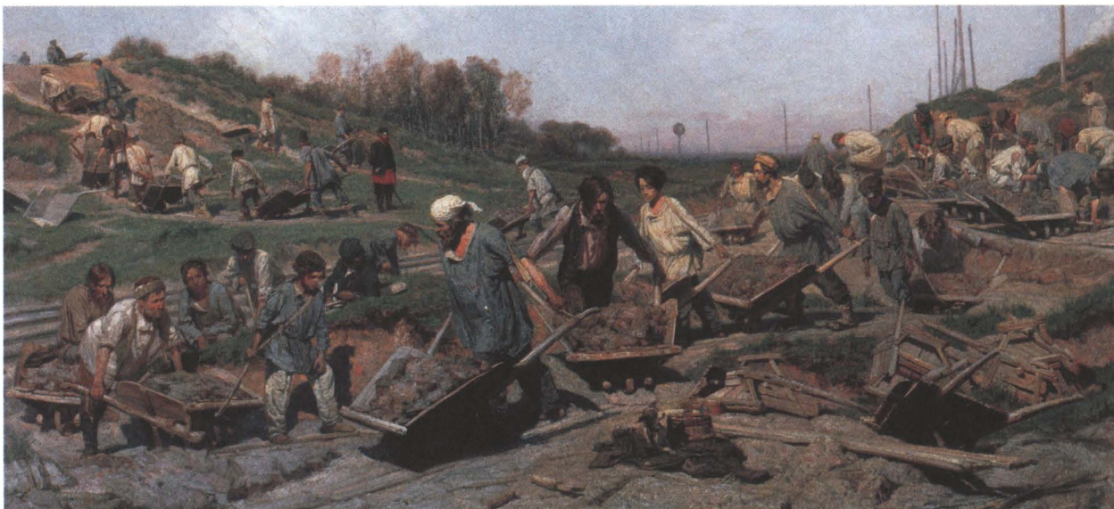
К. Савицкий. Ремонтные работы на железной дороге. Фрагмент
