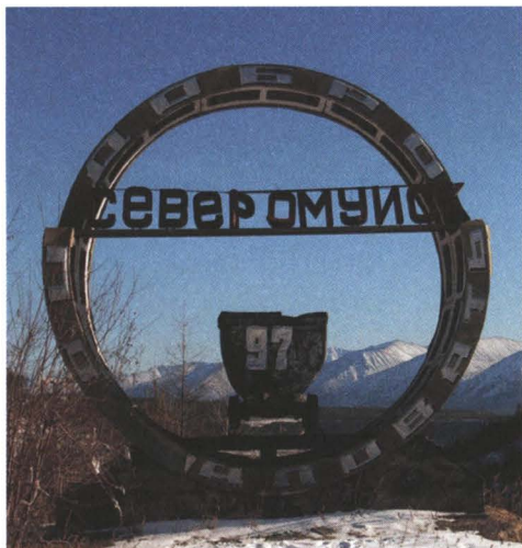
Северо-Муйский тоннель. Въездной знак – вагонетка в кольце
