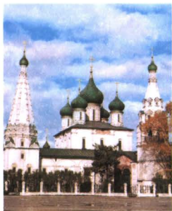
Церковь Ильи Пророка в Ярославле
