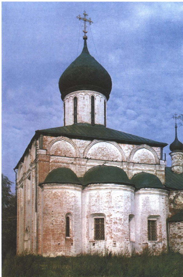
Троицкий собор Данилова монастыря. 1532 г. Вид с юго-восточной стороны
