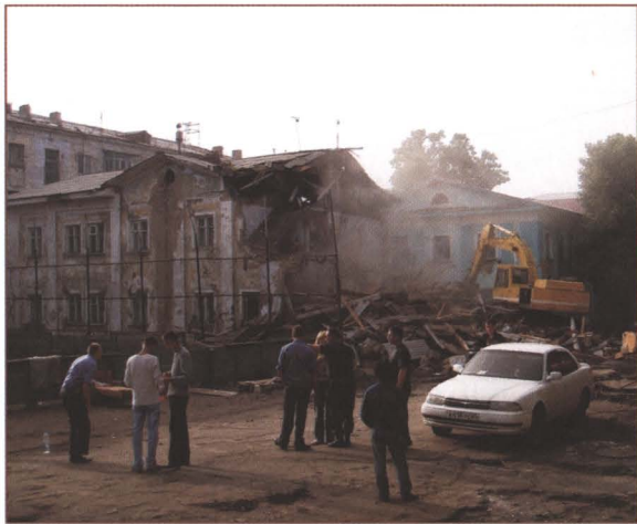
Последствия землетрясения в Невельске 2 августа 2007 года
