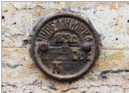
Рис. 2. Вид марки технического нивелирования 1872-1874 г.г. («марка Савицкого»).
