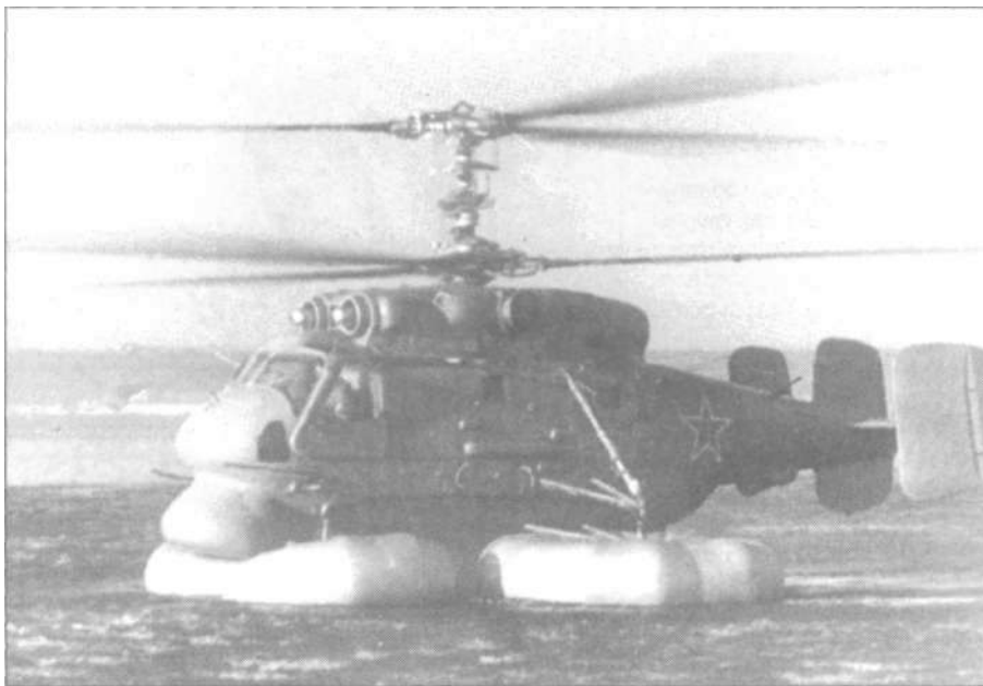
Испытания Ка-25 на надувных баллонетах.
