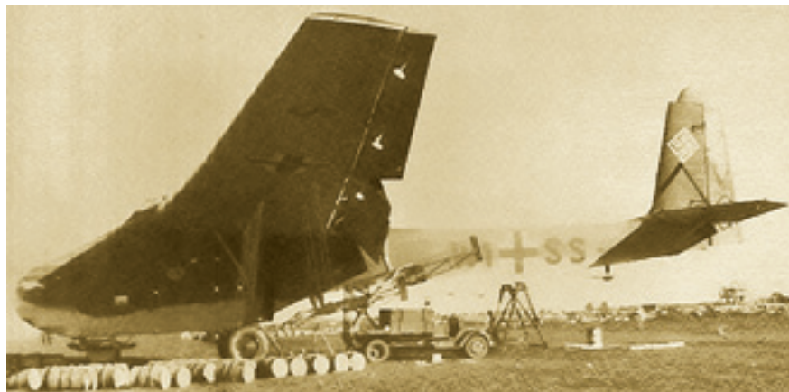
Подготовка Me 321A1 к боевому вылету. Закрылки выпущены в посадочное положение. Перед планером видны бочки с горючим. Их загрузят в Гигант
