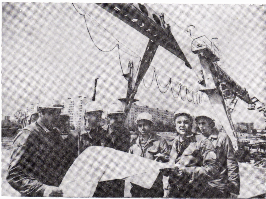
№ 0-53623 Чехословацкие метростроители на строительстве станции «Пражская» Московского метрополитена. 1984 г.
