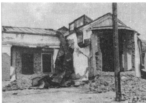
Здание архивного отдела и ЦГА ТССР, разрушенное землетрясением 6 октября 1948 г.
