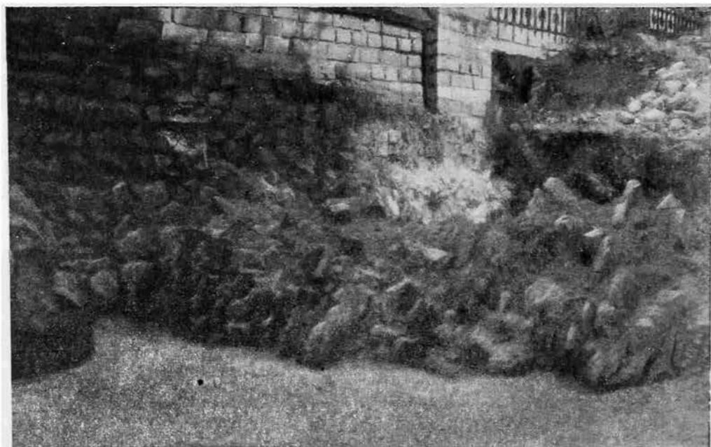
Рис. 5. Кладка упавшей западной стены.
