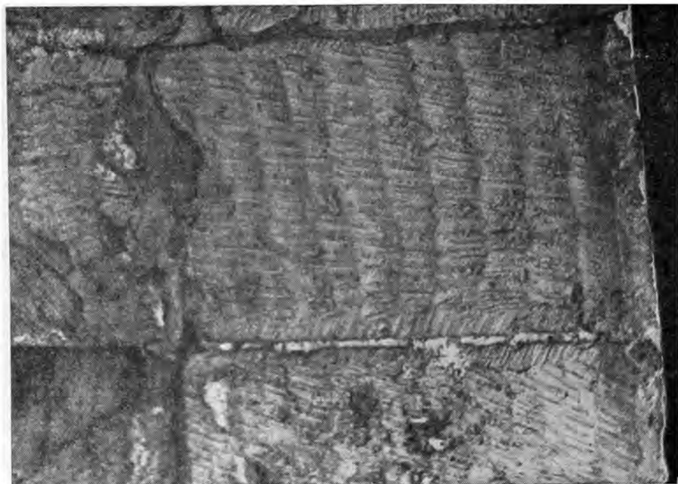
Рис. 3. Подпругная арка свода под переходом к Рождественскому собору в Боголюбове. Обработка тесовиком с профильной заточкой
