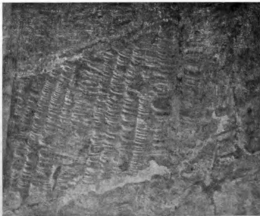
Рис. 4. Кладка западной щеки северо-восточного столба в церкви Покрова на Нерли. Обработка тесовиком с профильной заточкой
