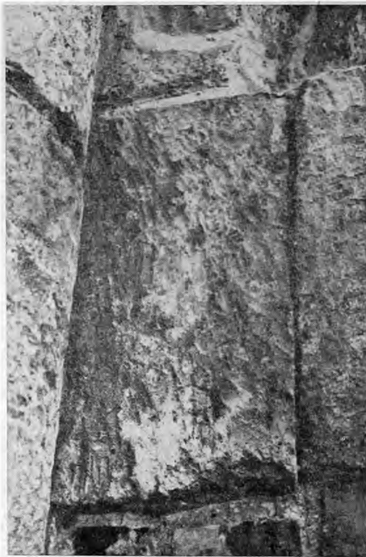
Рис. 6. Западный портал Георгиевского собора в Юрьеве-Польском. Фрагмент. Обработка тесовиком с прямым лезвием
