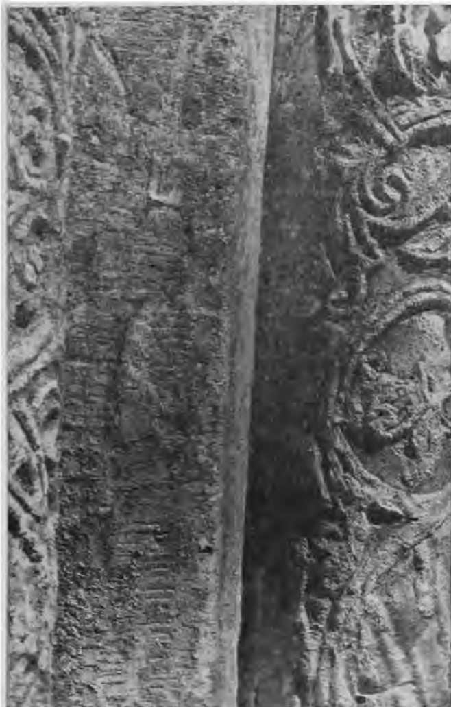
Рис. 5. Западный фасад северного перехода к Рождественскому собору в Боголюбове. Обработка теслом
