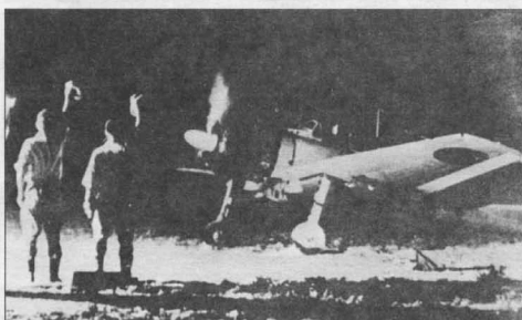
А6М3 модель 32 уходит в ночной полет, хорошо видна «обрезанная» законцовка крыла.
