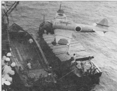
Перезука истребителя А6М21 с баржи на транспорт, законцовки крыла самолета сложены. Фюзеляжный опознавательный знак «хиномару» имеет белую окантовку, что редко встречается на полностью серых «зеро».
