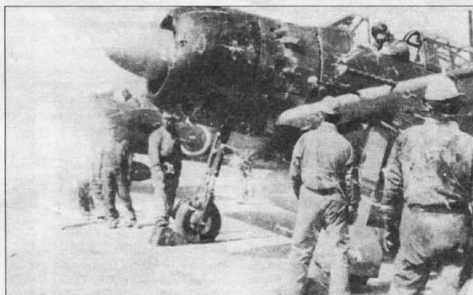
А6М5с модель 52с из Ютабе кокутая готовят к боевому вылету на сопровождение камикадзе, которым предстоит нанести удар по американскому десанту на Окинаву. «Зеро» модель 52с получил два дополнительных крыльевых 13-мм пулемета, по одному в каждой плоскости с внешней стороны пушек.
