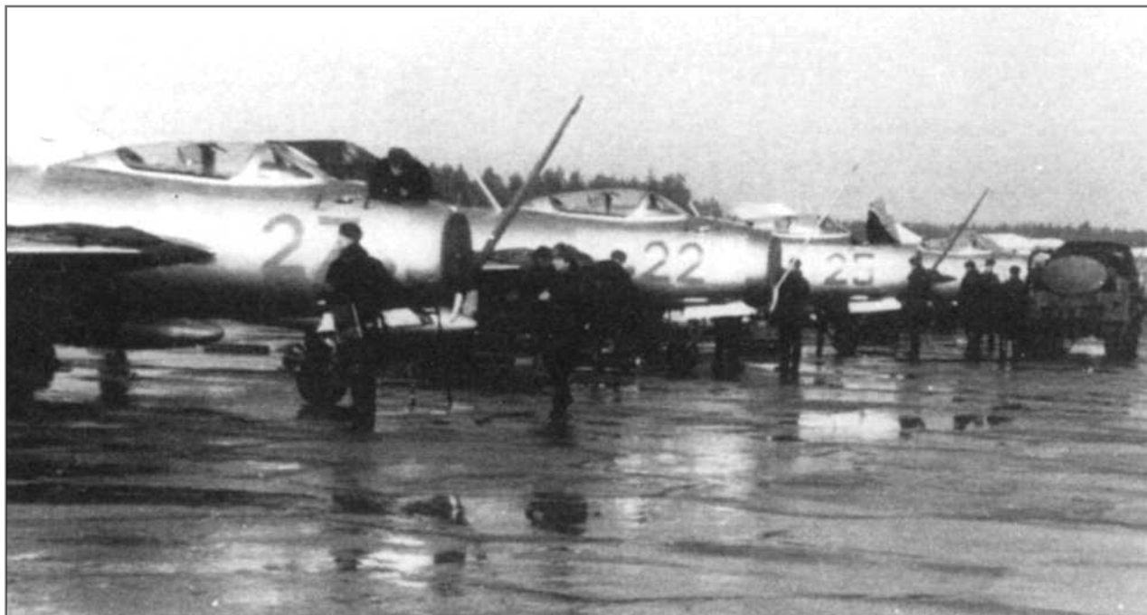
Линейка МиГ-19 на стоянке советской авиабазы. На стоянке носовая штанга поднималась, чтобы избежать травматизма среди персонала и не быть поврежденной аэродромной техникой. Бортовые номера, начинающиеся с 20, указывают, что самолеты принадлежали 2-й эскадрилье, а их синий цвет означает, что часть относится к войскам ПВО. Все МиГ-19 оснащены 760-литровыми подвесными баками.
