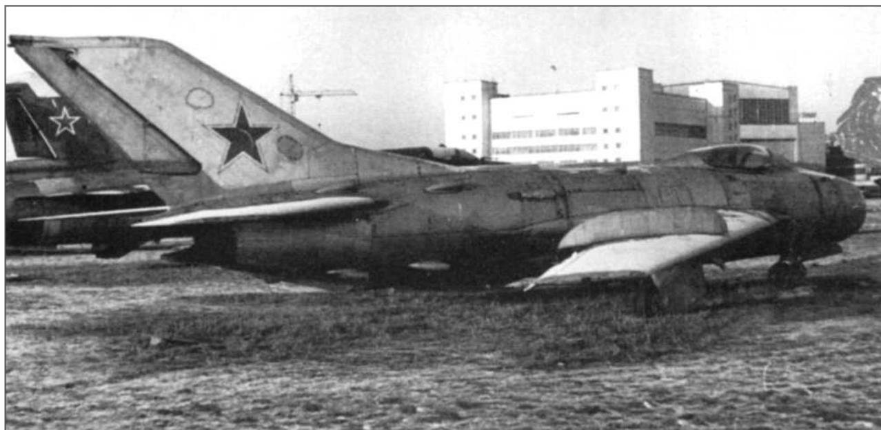
После завершения летных испытаний, МиГ-19СВ «17 красный», был помещен на хранение. Эта модификация имела такое же вооружение, как и МиГ-19С и небольшие усиливающие накладки на фюзеляже. В хвостовой части самолета располагались четыре больших воздухозаборника системы охлаждения.
