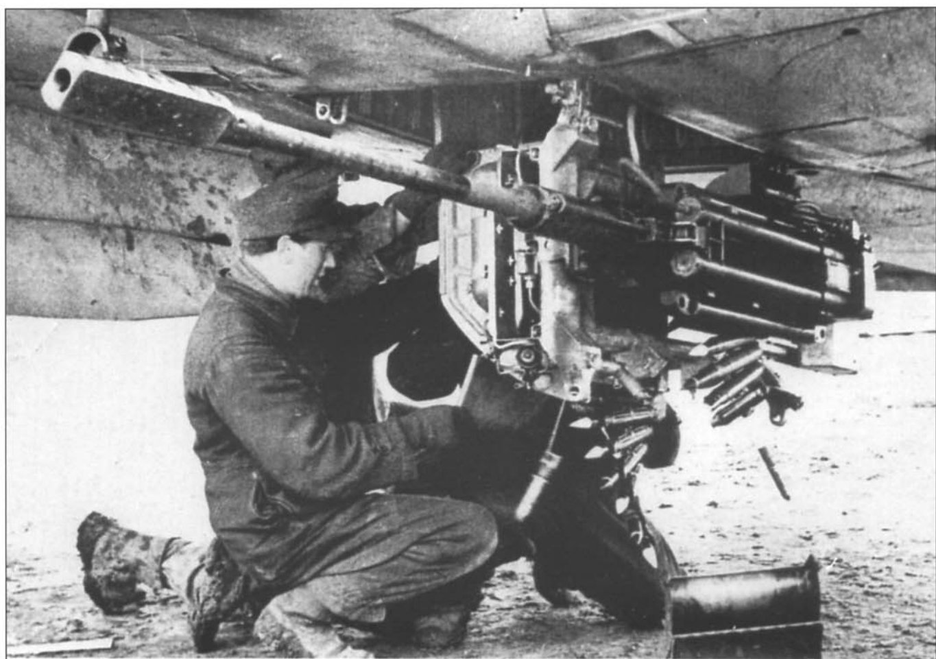
Зарядка пушки МК 103 снарядами в полевых условиях. Снаряды такой пушки пробивали броню в 75 мм на дистанции в 300 метров. Сама пушка в полуопущенном положении.
