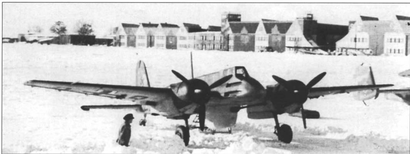
Рашиий Hs 129B-2 W.Nr.0280 (DQ+ZO), вооруженный пушкой Flak 18. Обратите внимание на пламегаситель, который защищал летчика от вспышек при стрельбе.
