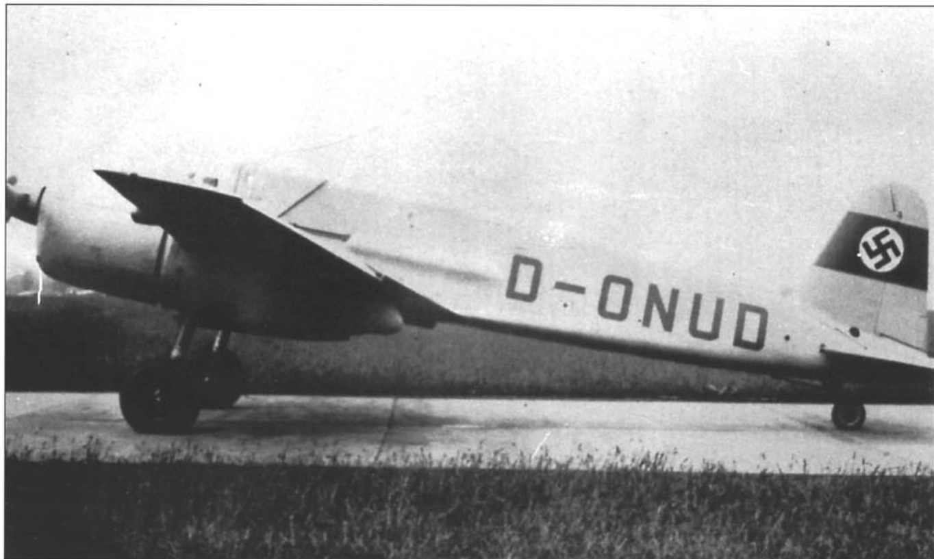
Победитель конкурса на истребитель двухмоторный Hs 129, изначально разработанный как истребитель. На фото Hs 129 V-1 (D-ONUD, W.Nr. 1293001), полностью покрашенный светло серым RLM 63. Фотография сделана в мае 1939 года перед первым полетом. Позже самолет получил камуфляж RLM 70/71 + RLM 65 и радиокод TF+AM.
