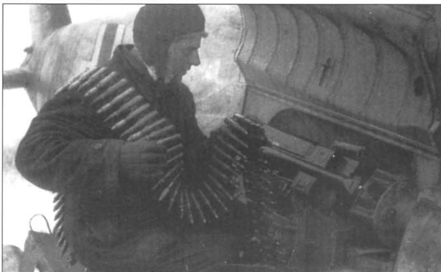
Оружейник укладывает ленту MG 151
