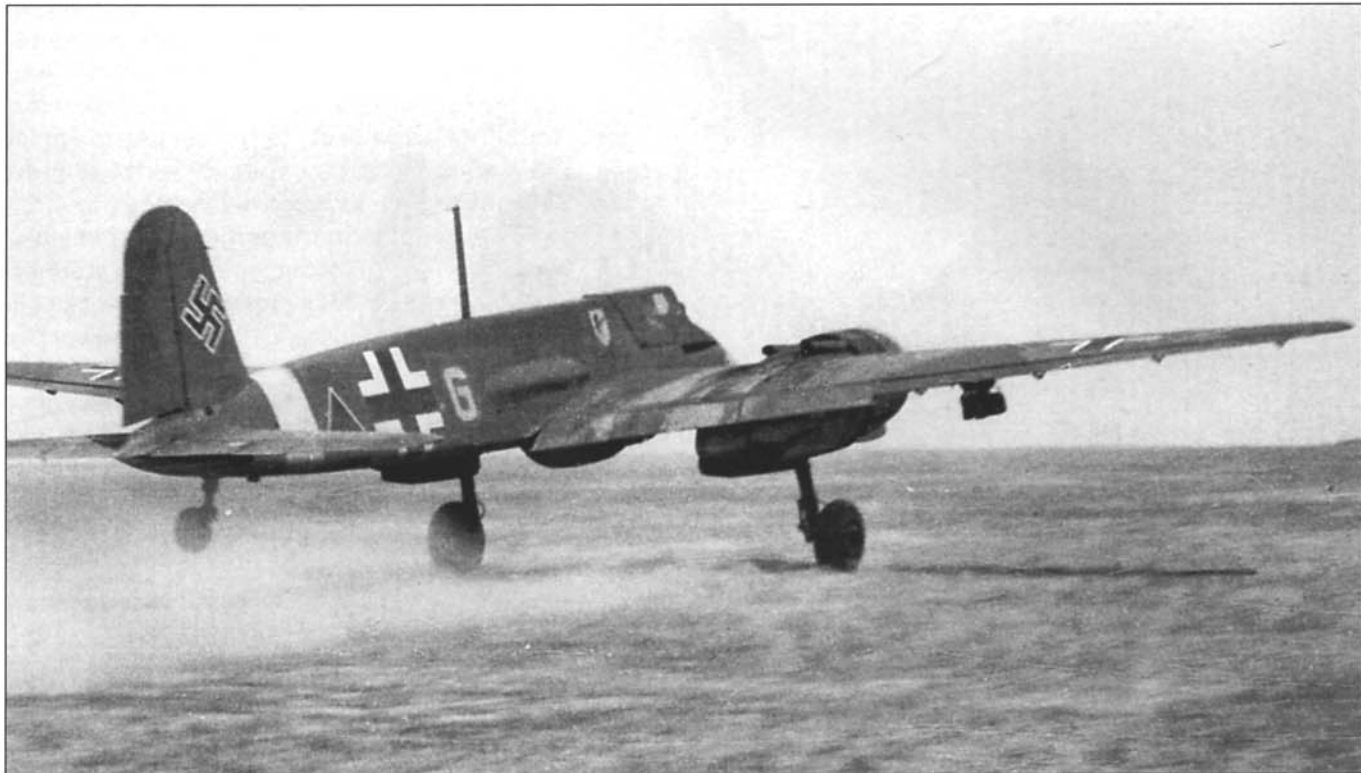
Взлетает «Хейнкель» Hs 129 В-2 «Желтая G» из состава II./Sch.G. 1. Самолет вооружен подфюзеляжной 20-мм пушкой МК 101, которая стала использоваться на самолетах этого типа с июня 1942 года. Обратите внимание на эмблему подразделения, нанесенную сразу за кабиной. Черный треугольник на фюзеляже обозначает принадлежность к истребительной авиации.
