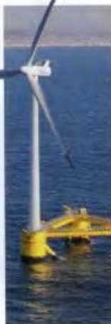
Плавающий ветрогенератор у берегов Португалии. Мощность такого устройства – 2 МВт
