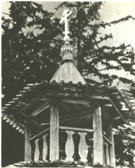
Колокольня часовни Параскевы Пятницы и Варлаама Хутынского в деревне Подъельники. XIX в. Вид с юго-запада.
