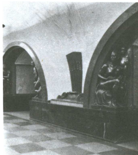
Станция метро «Площадь Революции». Часть перронного зала.
