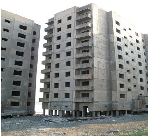
Рис. 5. Строительство на вечной мерзлоте
