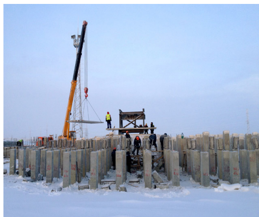
Рис. 4. Строительство на вечной мерзлоте
