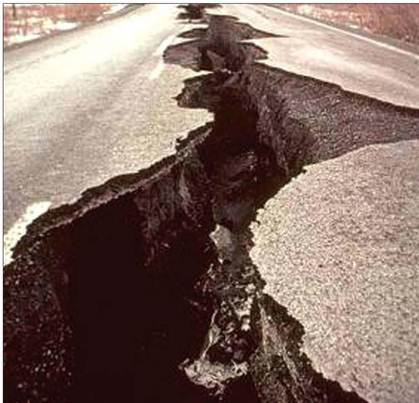
Рисунок 10. Трещина на шоссе, образовавшая из-за землетрясения
